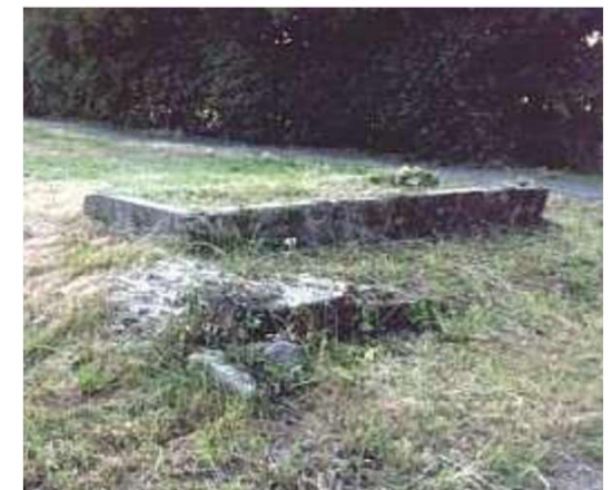
Eventueel nog zichtbare fundament
