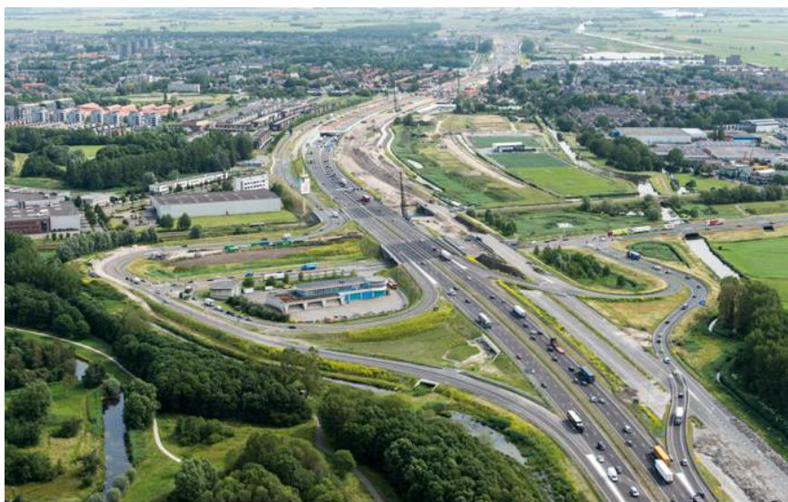
1.24- Het knooppunt van de A4 met de N11 en de Willem van der Madeweg te ter hoogte van Leiden en Zoeterwoude-Rijndijk. In de linkerhoek is de groene omlijsting van het Polderpark Cronesteyn zichtbaar (© Rijkswaterstaat, Foto: Joop van Houdt Luchtfotografie).
